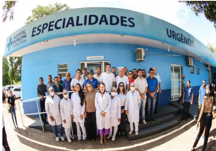
Figura 19 - Hospital Municipal Dr. Silas Freitas em Mãe do Rio
